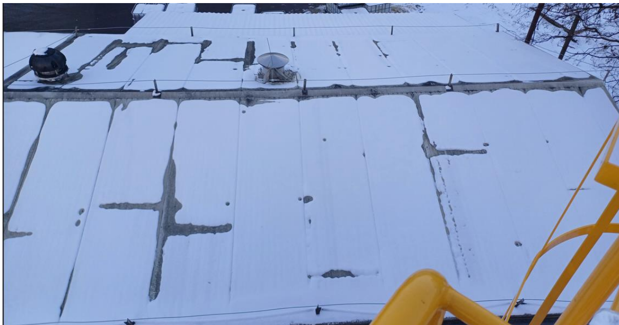
Fot. Zadaszenie nad częścią 3 – dach dwuspadowy
