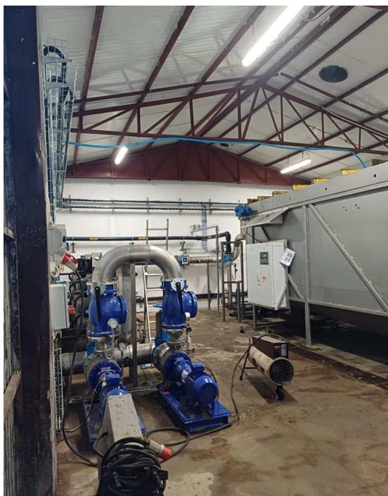
Fot. Wnętrze – część 3
