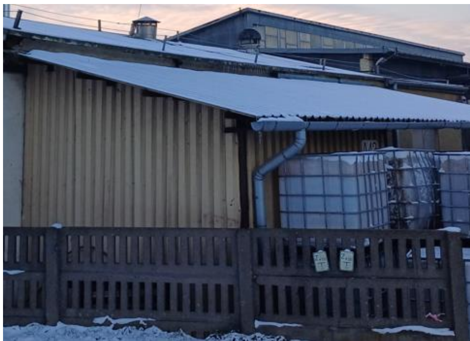
Fot. Ogólny widok na część 1
