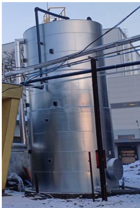
Fot. Widok fundamentu zbiornika części stałych
