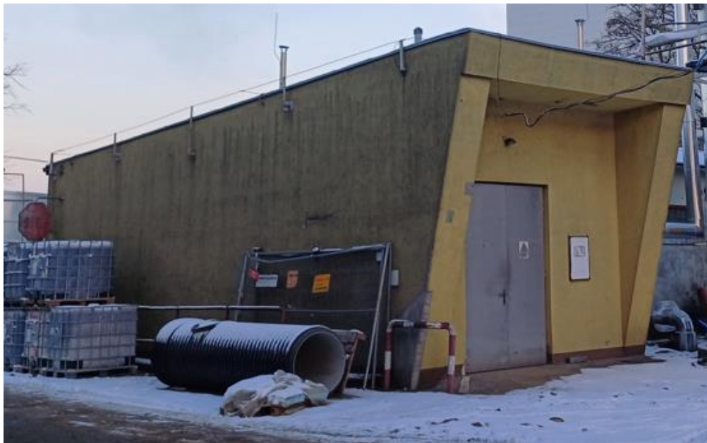
Fot. Ogólny widok na część 2
