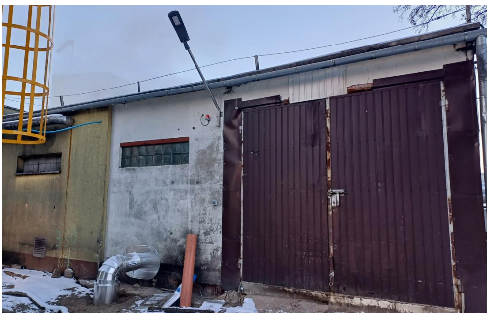
Fot. Ogólny widok na część 3
