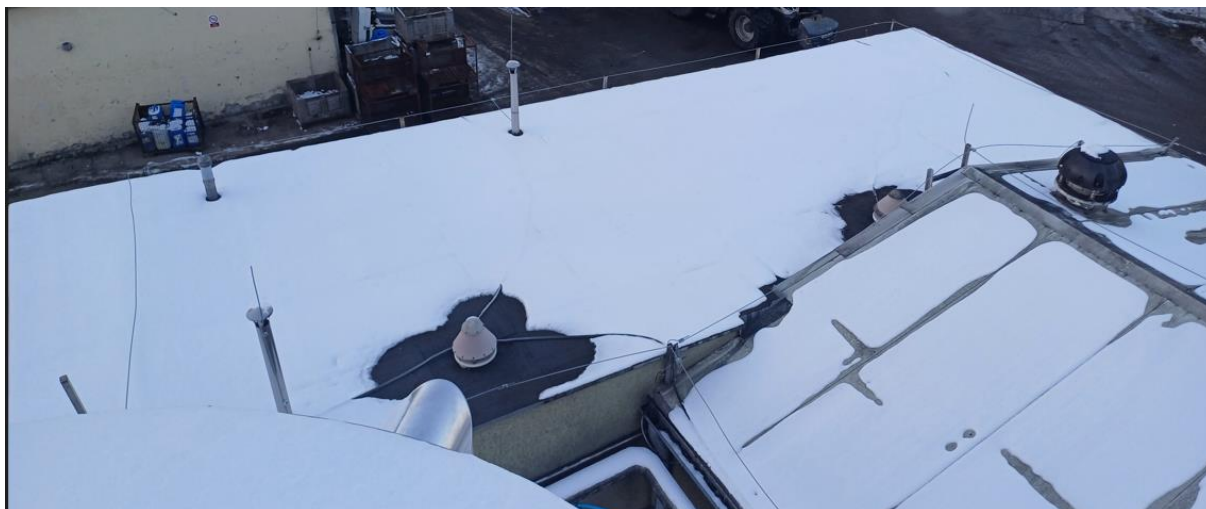
Fot. Zadaszenie nad częścią 2 – dach jednospadowy
